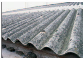
Crédits : INRS Toiture en amiante ciment
