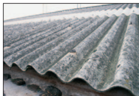
© INRS Toiture en amiante ciment
