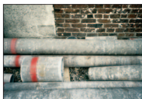
Crédits : INRS Canalisation en amiante ciment
